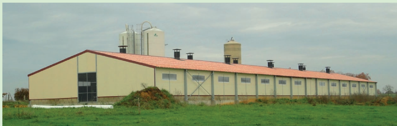
Bâtiment veaux de boucherie.
